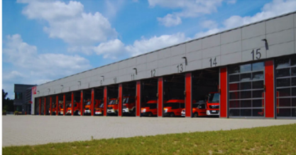
Fahrzeughalle der Freiwilligen Feuerwehr Kalkbücken, inkl. einer Brandmeldeanlage (Quelle: FF Kalkbücken)
